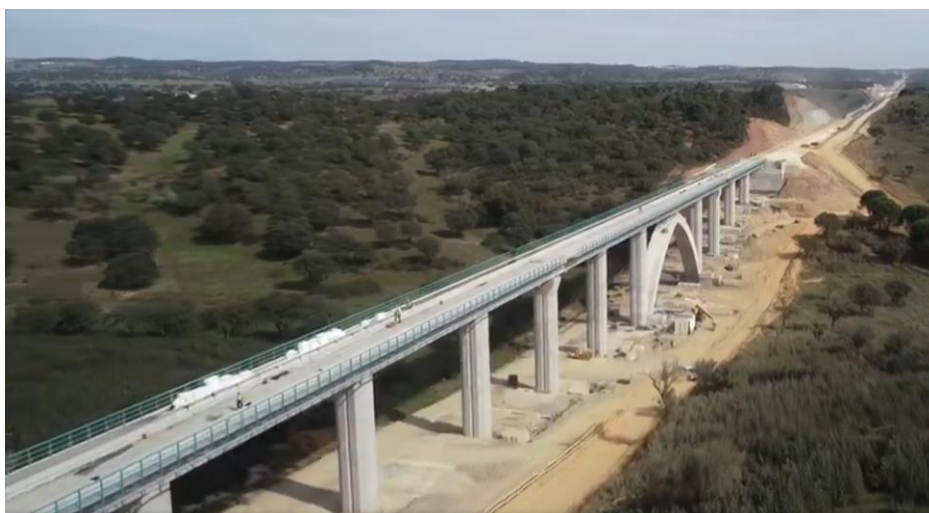
Fig. 9: Imagem aérea da Ponte do Barranco dos Galvões (fonte; Mota Engil Engenharia, SA)
