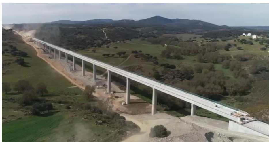
Fig. 10: Imagem aérea da Ponte do Lucefece (fonte: Mota Engil Engenharia, SA)
